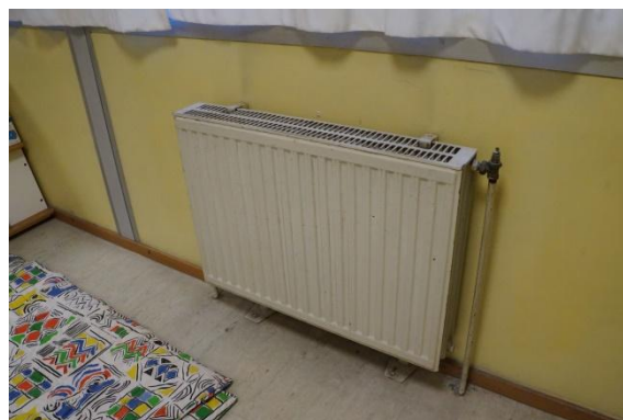
Figura 4.8 - Particolare di un radiatore installato all'interno di un ambiente di lavoro
