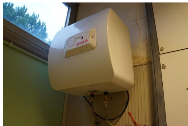
Figura 4.15 - Particolare di un boiler elettrico per la produzione di acqua calda sanitaria
