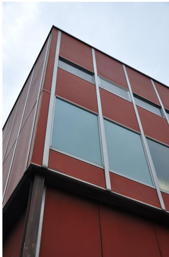
Figura 4.1 – Particolare dei pannelli prefabbricati della facciata
